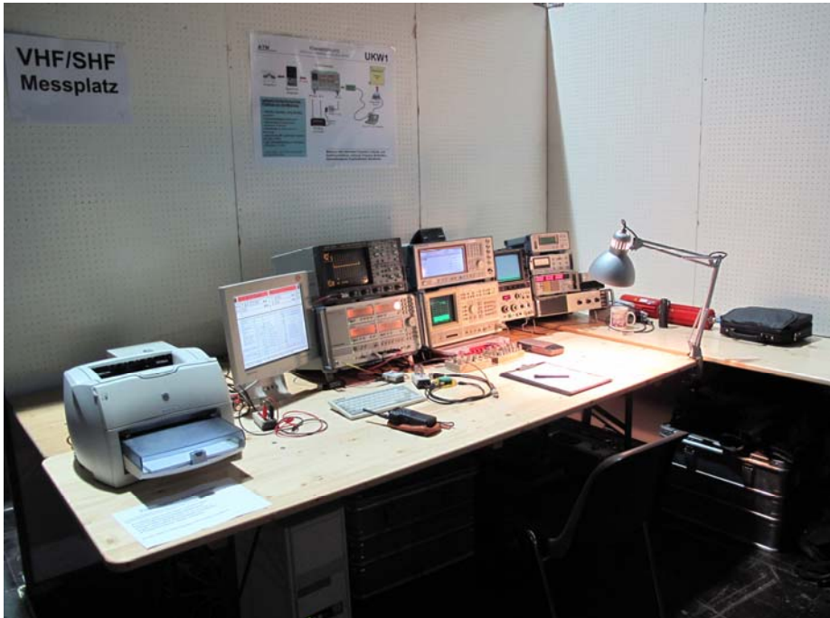
Abbildung 1: einer der ATN-Messplätze auf der INTERRADIO
